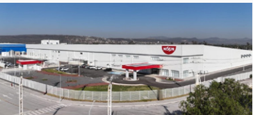
2026年春に稼働したアパセオ工場
