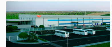
建設中のポンタグロッサ工場(イメージ)
